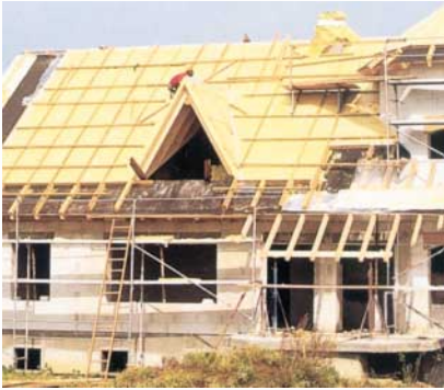
De HECO-TOPIX® is ideaal te gebruiken voor de bevestiging van isolatiemateriaal op dakspanten
