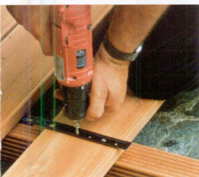
Montage de terrasses
